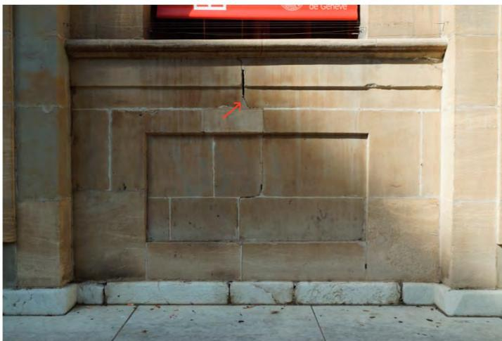
Fig. 98: On observe des fissures verticales sur les deux tablettes des fenêtres au RDC (à côté de la porte d'entrée). Des pierres ont été déjà remplacées. Ces fissures éloignées des joints pourraient résulter de problèmes de tassements différentiels. Façade sud-est.
