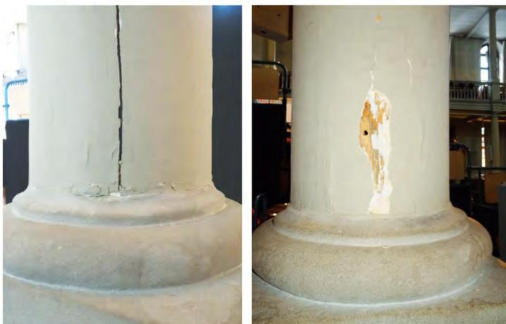
Fig. 170-171: Détail des colonnes au RDC. On distingue une couche de stuc en plâtre sur le bois légèrement vermoulu. (6)
