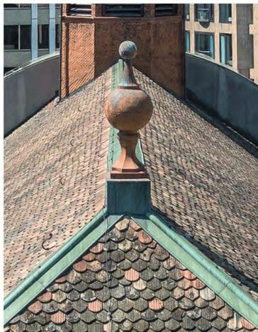
Fig. 103. Épi de faîtage en zinc peint et arrêtiers en cuivre naturel oxydé sur le côté nord-est de la toiture.
