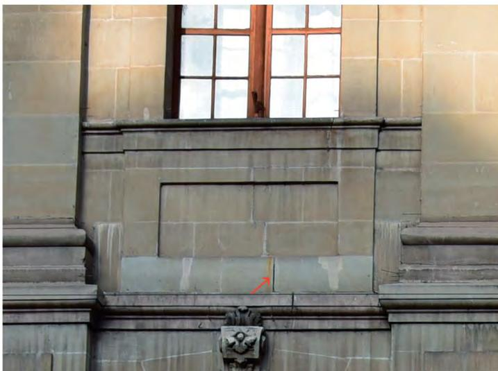
Fig. 100. On observe des fissures verticales sur les tablettes de plusieurs fenêtres à l'étage. Ces fissures éloignées des joints pourraient résulter d'une poussée consécutive à un défaut structurel au niveau de la charpente de la galerie et/ou à un problème de tassements différentiels. Façade sud-est.
