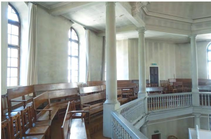
Fig. 205. Vue générale de la galerie et cage d'escaliers sud-est. Selon LRD, les éléments de bois verticaux constituant les parois des deux cages d'escaliers sont datés de différentes époques : 1352, 1397, 1423 et 1429. Ces parois sont des remplois des matériaux extraits du «tissu» médiéval.
