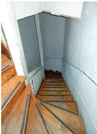
Fig. 198: Vue plongeante de l'escalier sud-est. Les marches ont été rénovées en 1976 avec resselelage en chêne.
