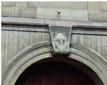
Fig. 105: Clé d'arc sur porte principale, façade sud-ouest, avec modillon et feuille d'acanthé.
