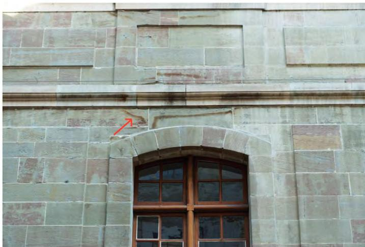
Fig. 91: Points de concentration d'eau, taches d'humidité et desquamation des pierres alentours.
