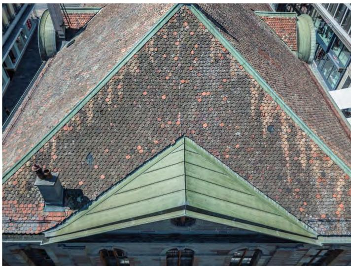
Fig. 117: Vue sur la croupe nord-est avec le petit tympan couvert de bardage en cuivre naturel. Vol de drone O. Chamard
