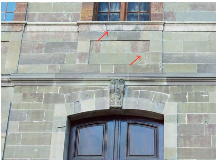
Fig. 77. On observe des fissures verticales sur une des tablettes d'une fenêtres à l'étage. Cette fissure éloignée des joints résulte probablement d'un tassement différentiel. Façade nord-est.
