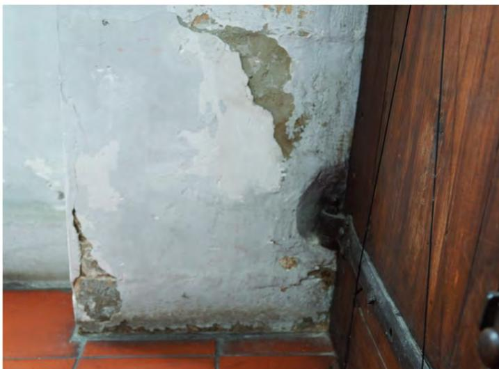
Fig. 165: Ebrasement en masse de la porte latérale sud au RDC. On aperçoit une peinture beige qui se détache sur cet élément. (18)
