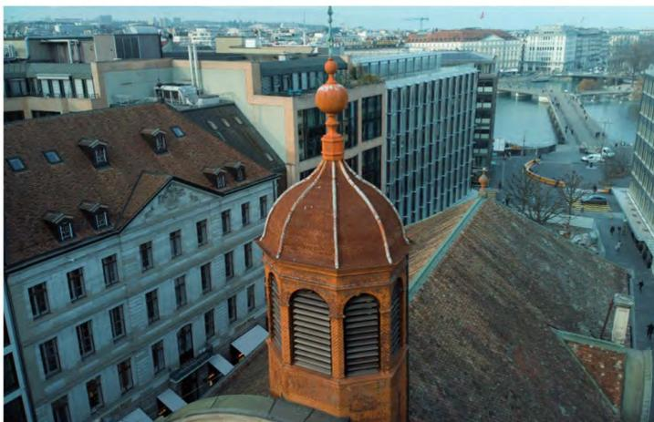
Fig. 120. Vue du clocher. Vol de drone O. Chamard. On distingue nettement le bardage en écailles de fer blanc peintes. Ces écailles sont très corrodées.
