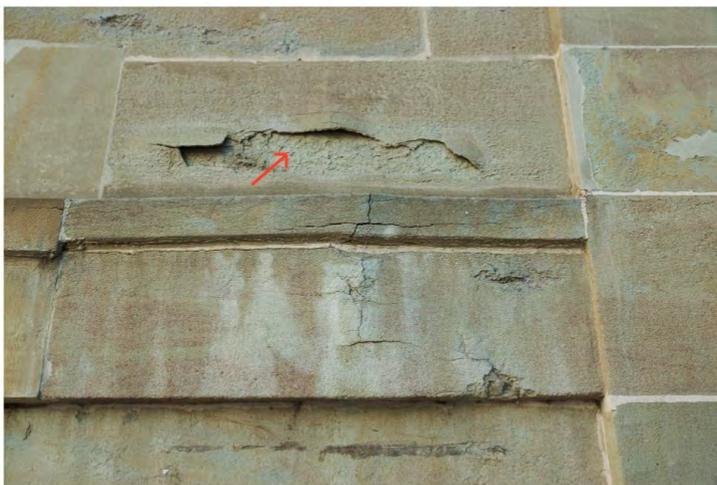
Fig. 84: Vue détaillée de la desquamation superficielle des pierres. Cordon en molasse à gauche de la porte. Façade nord-est. Délitements des tablettes et cordons. On distingue un délitement conjugué au problème de fissure transversale perpendiculaire au lit de la pierre. Des efforts dus aux tassements différentiels en sont probablement la cause.
