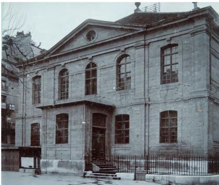
Fig. 27: Façade nord avec tambour d'entrée. 1910. Avant la restauration. On distingue les fortes dégradations sur la molasse. Prov. CIG.
