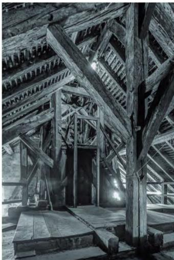
Fig. 301: Surcombles. Côté nord. Avec au fond le beffroi supportant la chaire et le clocher.
