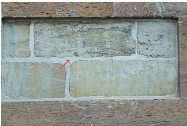
Fig. 92. Des joints en ciment d'une teinte plus claire que la pierre, ont été faits en 1976. La composition de ces joints est incompatible avec la nature de la pierre. Ils sont trop étanches et durs. Façade ouest.
