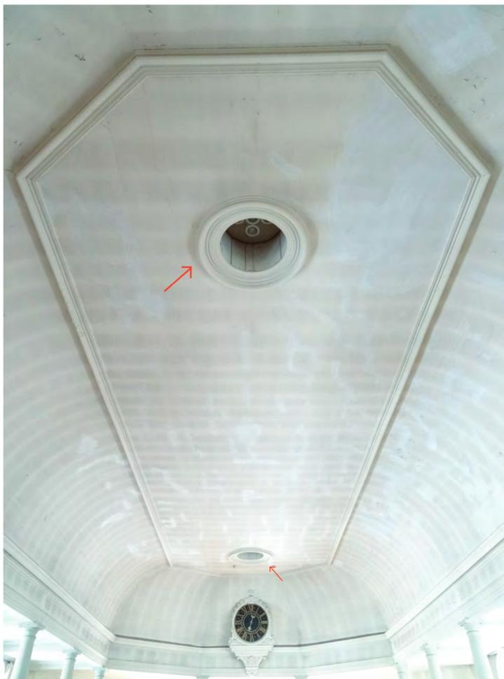
Fig. 215: Vue de la voûte et de deux oculi donnant sur les surcombles. Ces éléments comportent des dispositifs de luminaires obsolètes, type spots.
