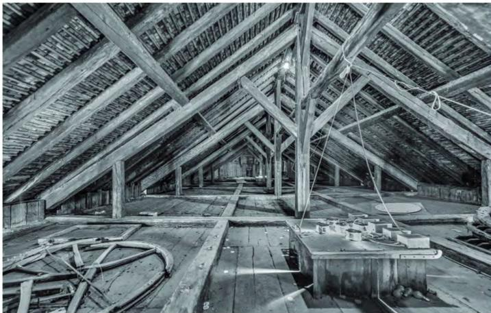
Fig. 299. Surcombles. Côté sud. Charpente à fermes avec entrails retroussés coïncidant avec le niveau supérieur du couvrement de la grande voûte.
