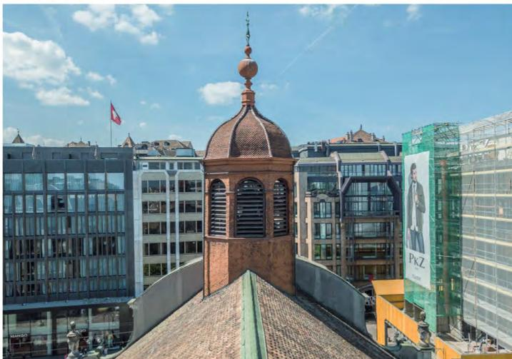
Fig. 119. Vue du clocher. Le clocher est intégralement recouvert d'écailles. On en dénombre trois types sur les faces intérieures du bahut, jusque sous les tablettes des embrasures cintrées. Les plus anciennes écailles, probablement datées de la restauration de 1859, sont en fer blanc, elles ont été profilées à la main. Les deux autres sortes, plus récentes, sont en tôle galvanisée et ont été profilées industriellement, par estampage. Vol de drone O. Chamard.
