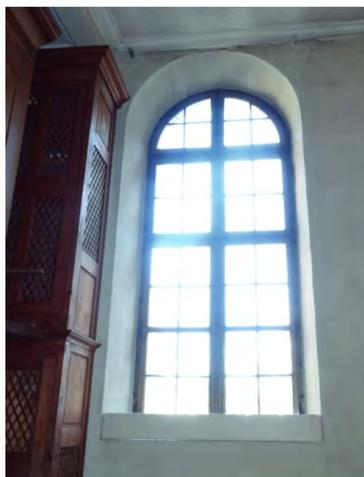
Fig. 259: Fenêtre 53. Fenêtre à la française en arc plein cintre.
