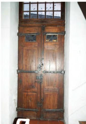
Fig. 184: Porte 19 avec attique vitré en noyer. Porte et ferrements datant de la construction d'origine.
