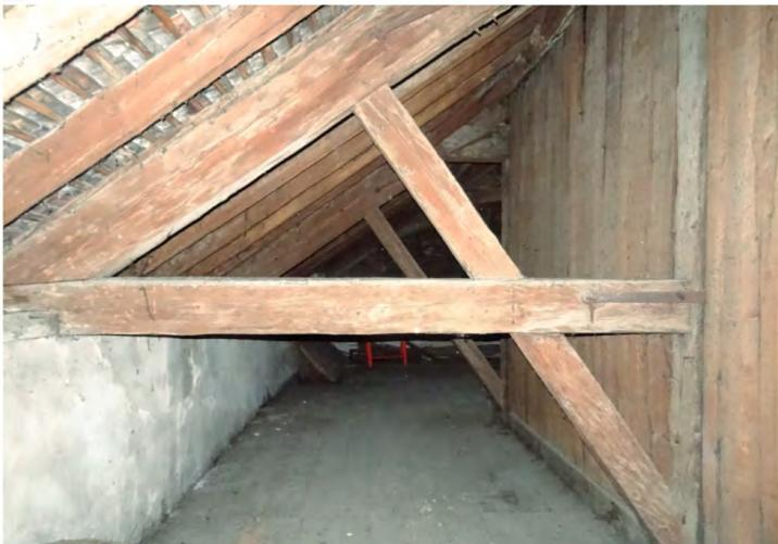
Fig. 275. Combles. Côté sud-ouest et ouest. Les zones à traiter suite aux infiltrations se situent au niveau des appuis sur les pannes sablières. Constats ponctuels de pourriture. Les dégâts d'eau sur ces zones sont récurrents.
