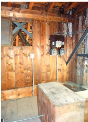
Fig. 303: Tableau d'alimentation de l'éclairage de l'horloge, avec transformateurs sans protections. A mettre aux normes.
