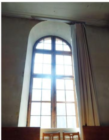
Fig. 263: Fenêtre 58. Fenêtre à la française en arc plein cintre.
