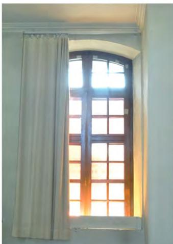
Fig. 188: Fenêtre 23. Fenêtre à la française en arc bombé (segmentaire). Double fenêtre à l'intérieur posée dans les années 1912.
