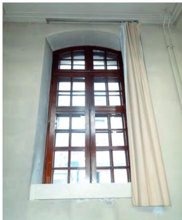
Fig. 173: Fenêtre 3. Fenêtre à la française en arc bombé (segmentaire). Double fenêtre à l'intérieur posée dans les années 1912.
