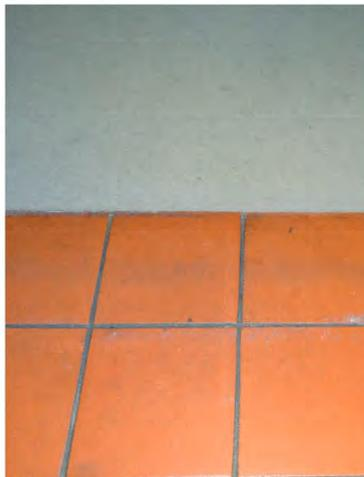
Fig. 164: Vue détaillée du sol en terre cuite (tomettes) datant de 1975 et moquette dans la partie centrale de la nef. (10)
