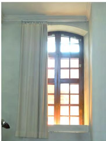
Fig. 183: Fenêtre 17. Fenêtre à la française en arc bombé (segmentaire). Double fenêtre à l'intérieur posée dans les années 1912.
