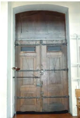
Fig. 174: Porte 4, monumentale, en noyer. Porte et ferrements datant de la construction d'origine. Celle-ci ainsi que les autres portes noyer, seront adaptées aux normes AEA1 par un asservissement invisible, dissimulé dans le sol.
