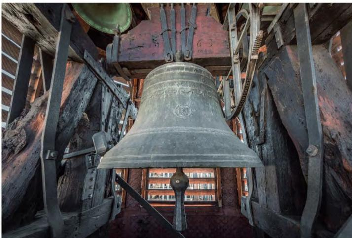
Fig. 125. Vue de l'intérieur du clocher. La grosse cloche, coulée par Jean Du Villard en 1607, se trouvait à l'origine dans la tour de l'horloge du Molard et fut transférée à la Fusterie en 1763. Son diamètre est de 111 cm. Image de O. Chamard.
