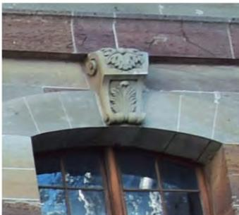
Fig. 106: Clé d'arc sur fenêtre, façade nord-est, avec modillon galbé en talon et feuille d'acanthé.
