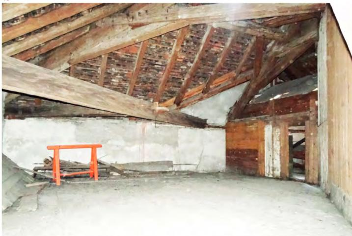
Fig. 280. La charpente est essentiellement en sapin et épicéa. L'intégralité des éléments sondés par LRD ont été datés à la coupe entre 1713 et 1714.
