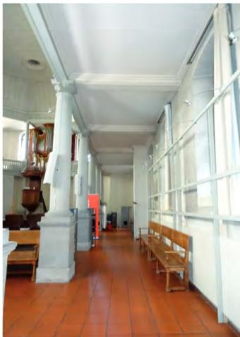
Fig. 163: Colonne au RDC. Socle en calcaire et molasse. (6)
