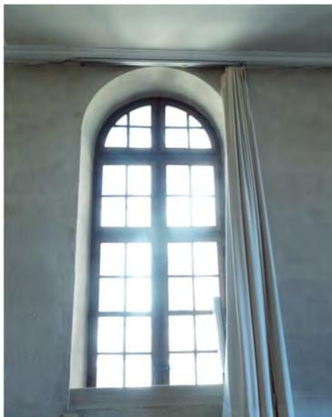
Fig. 255: Fenêtre 49. Fenêtre à la française en arc plein cintre.
