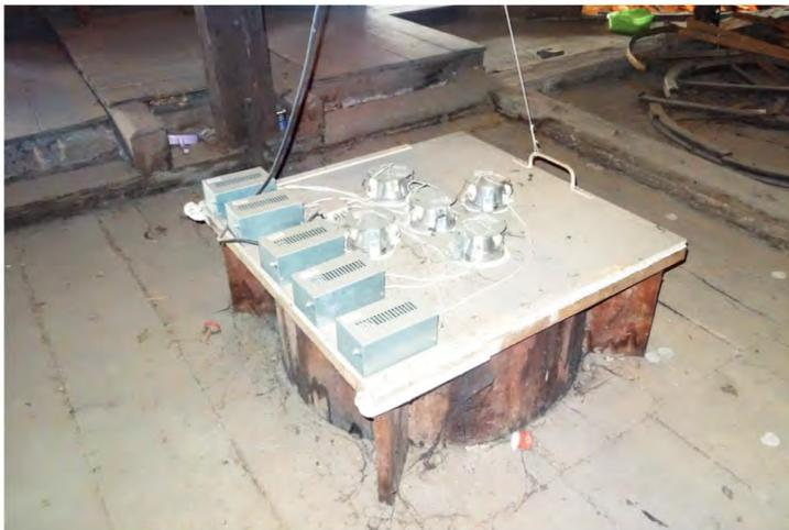
Fig. 300. Surcombles. Structure de fermeture des oculi servant de support pour les luminaires.
