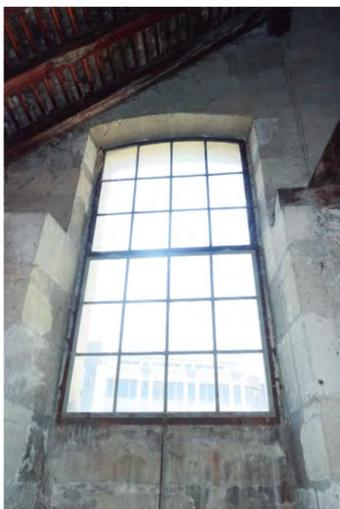
Fig. 311: Fenêtre 70, façade sud-ouest. Fenêtre métallique équipée en partie de verres soufflés. Verres float à remplacer par des verres soufflés.
