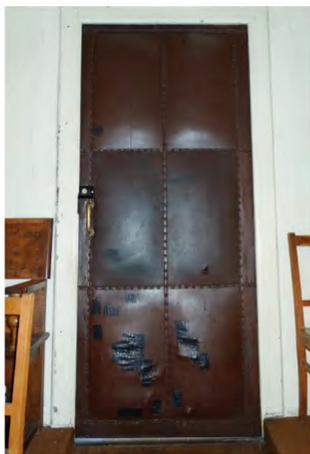
Fig. 266: Porte 56. Porte rembourrée en toile cirée, type moleskine à six «panneaux».
