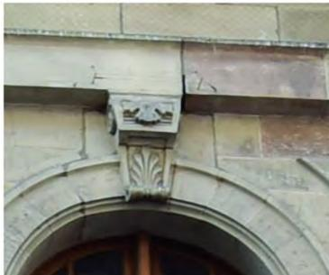
Fig. 109: Clé d'arc sur fenêtre, façade sud-est, avec modillon galbé en talon et feuille d'acanthé.
