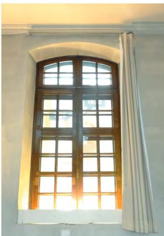
Fig. 182: Fenêtre 16. Fenêtre à la française en arc bombé (segmentaire). Double fenêtre à l'intérieur posée dans les années 1912.
