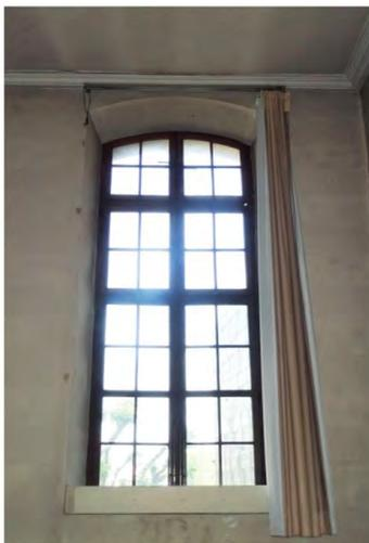
Fig. 260: Fenêtre 54. Fenêtre à la française en arc plein cintre.
