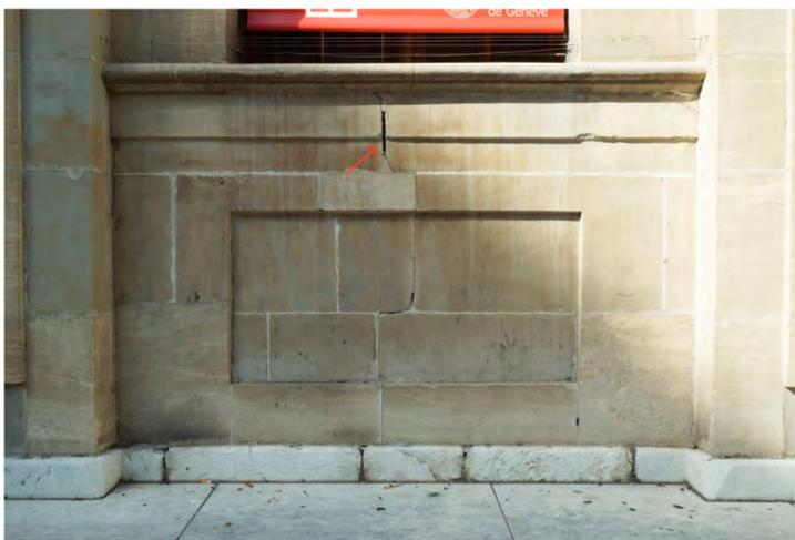
Fig. 241: Sur les façades, la fissure se prolonge de la tablette jusqu'au sol. Les fissures sont accompagnées d'une légère desquamation superficielle des pierres autour des joints. Le gel et l'humidité continus, dans des endroits plus sensibles et exposés, peuvent provoquer ce type de problème.
