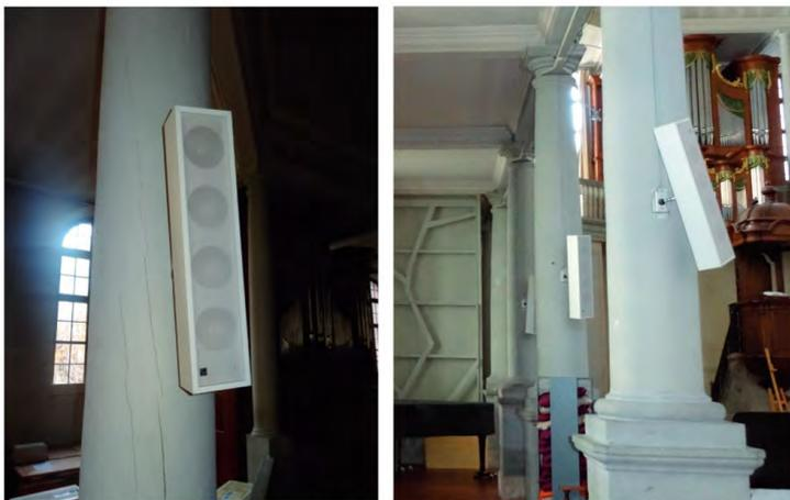
Fig. 340-341: Le système de sonorisation n'est plus en adéquation avec les nouveaux usages du bâtiment. Une étude acoustique est en cours afin de trouver un nouveau concept de son. Actuellement, les haut parleurs sont accrochés contre les colonnes.
