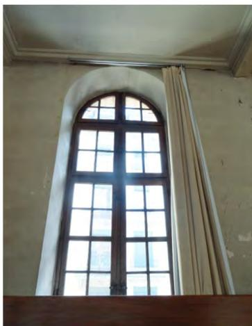
Fig. 247: Fenêtre 38. Fenêtre à la française en arc plein cintre.
