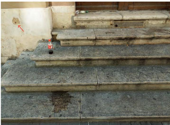
Fig. 96: On distingue de nombreuses souillures consécutives à l'occupation des badauds et aux passages des gens. Ce phénomène est principalement localisé sur les escaliers d'accès et sur le soubassement au RDC. On remarque aussi des dégâts sur le soubassement en calcaire. Il pourrait s'agir d'une ancienne main courante.
