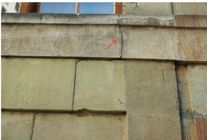
Fig. 76: On observe des fissures verticales sur la plupart des tablettes et contrecœurs des fenêtres du RDC.
