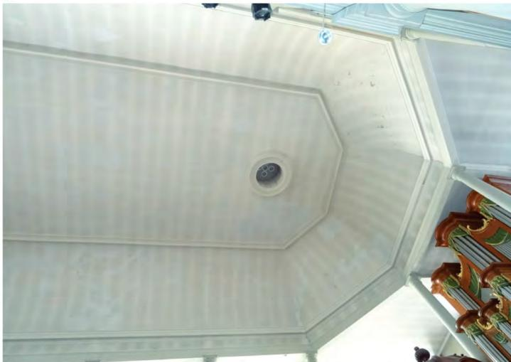
Fig. 213: Vue de la voûte. On distingue les stries dues aux ponts de froid. Les anciens oculi devaient servir pour la ventilation. Il se pourrait qu'ils coïncident avec l'installation de deux calorifères en 1834. En tout cas, on ne les distingue pas sur la vue gravée de P. Escuyer de 1822. Le rapport dendrochronologique identifie ces éléments comme datant de l'automne 1865.
