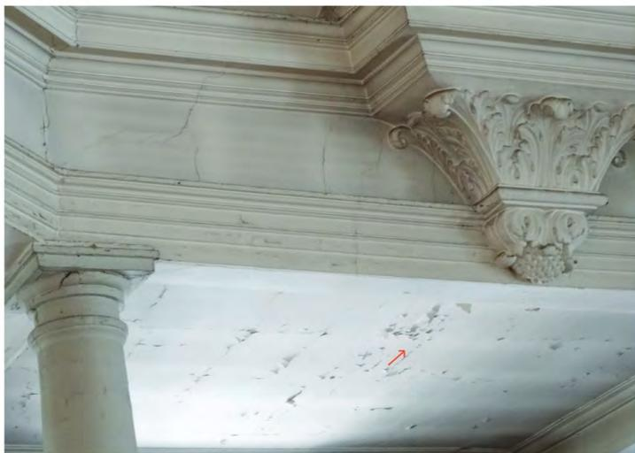
Fig. 230. Même cas de figure que les images 228-229. Peinture à la détrempe très altérée.
