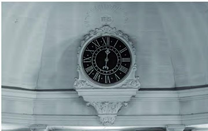
Fig. 143. Vue détaillée de l'horloge intérieure, dont l'aiguille est actionnée par l'horloge mère mécanique, datant de 1912 et construite par J.G. Baer
