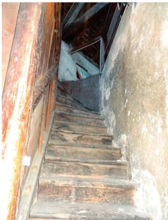
Fig. 270: Escaliers d'accès aux combles, marches en chêne. Datés par LRD de l'automne/hiver 1714. Les marches en bois sont en bon état mais très usées. Les murs à la chaux sont très fusés.
