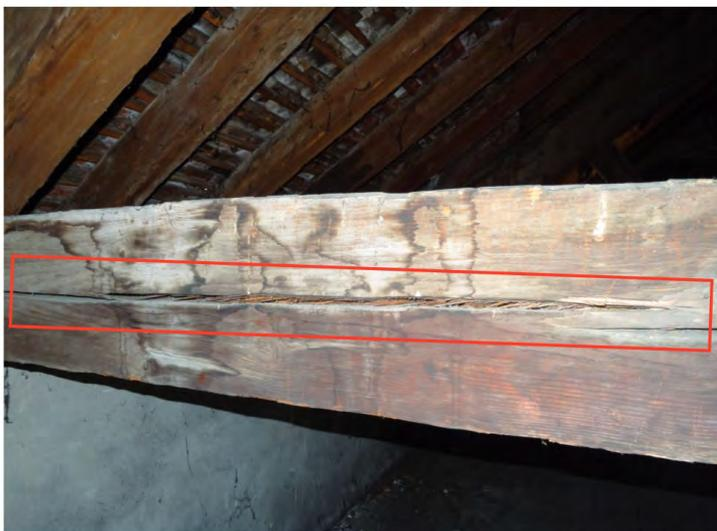
Fig. 294. On remarque de grosses fentes sur les blochets. Ces fissures sont des altérations dues aux efforts et à la qualité des bois concernés. Des problèmes d'infiltrations ont éventuellement aggravé ces fissures. Epicéa des années 1713/14 Bertrand Yertly -Réf. LRD15/R7210», Laboratoire Romand de Dendrochronologie.
