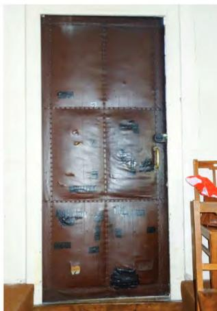
Fig. 267: Porte 60. Porte rembourrée en toile cirée, type moleskine à six «panneaux».
