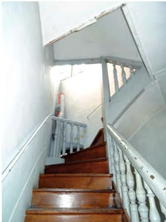
Fig. 153: Vue de l'escalier sud-est depuis le RDC. Le garde corps est daté par LRD de 1714/15.
