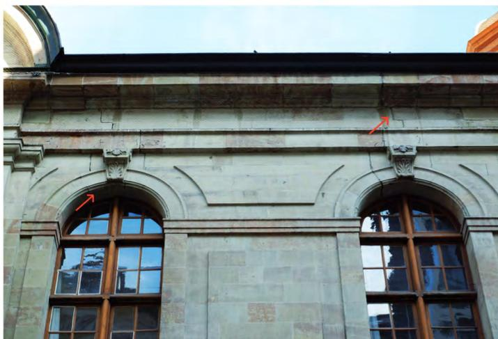
Fig. 239. Fissures qui vont de la clé jusqu'à la corniche. Voir point « 8.3.1 Éléments en pierre ».
