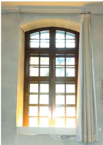
Fig. 180: Fenêtre 14. Fenêtre à la française en arc bombé (segmentaire). Double fenêtre à l'intérieur posée dans les années 1912.
