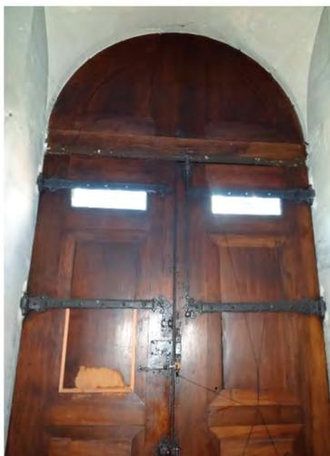
Fig. 187: Porte 22 en noyer. Porte et ferrements datant de la construction d'origine.
