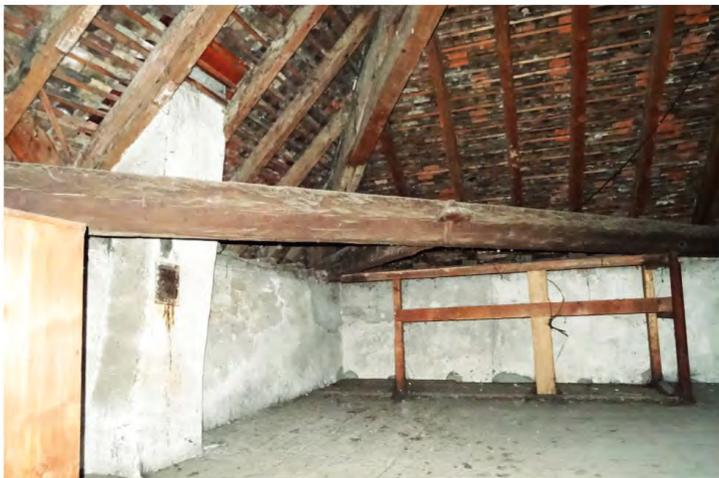
Fig. 291: Côté nord-est. Cheminée (conduit de ventilation kitchenette du RDC). On distingue les vestiges d'un ancien garde-corps sur le périmètre de la cage d'escaliers reliant la galerie et les combles.
