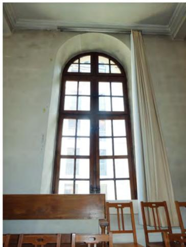
Fig. 243: Fenêtre 34. Fenêtre à la française en arc plein cintre.
