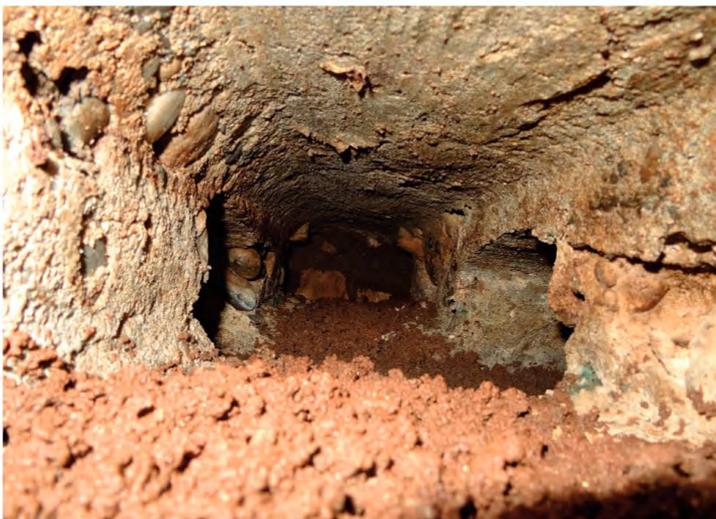
Fig. 322-323. Images fouille I. Atelier Féroué, 2016. Empreintes en négatif de poutres décomposées sous les fondations.
