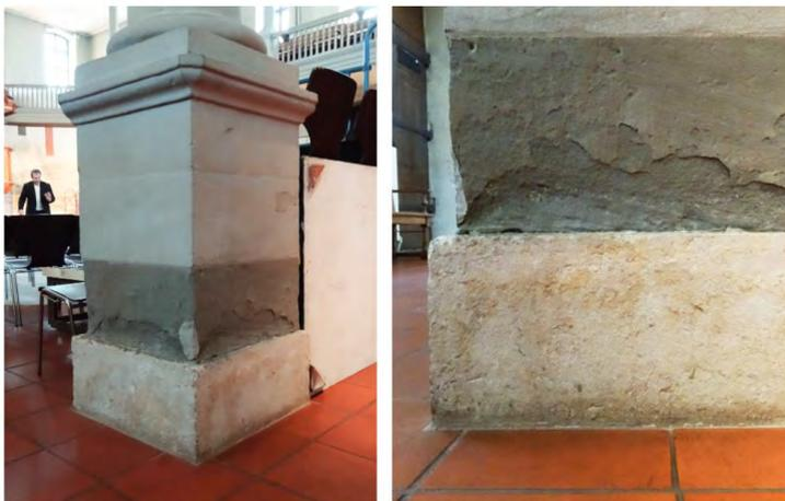
Fig. 166-167: Colonne au RDC. La base du piédestal, en calcaire de Thoiry, est en bon état. Le socle en molasse a souffert des desquamations superficielles plus importantes dans la partie basse, dues aux remontées capillaires, malgré les bases en calcaire. (11)
