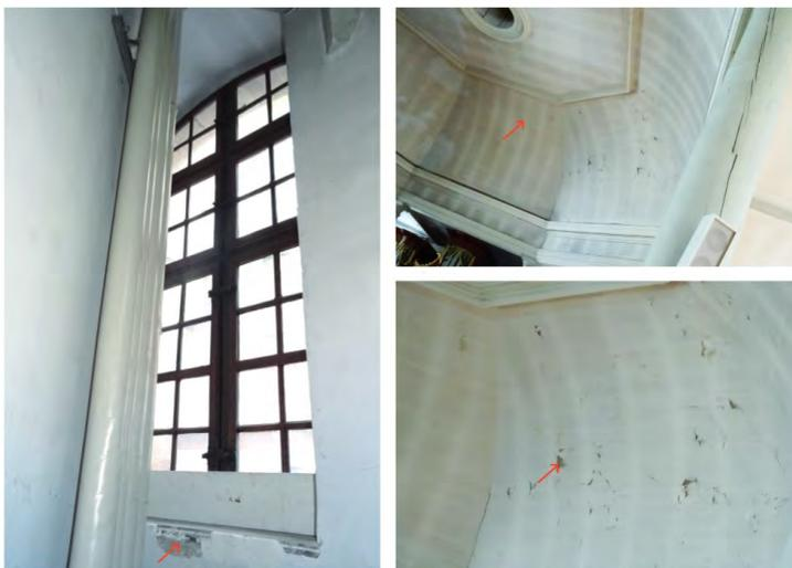
Fig. 227-228-229 Le plafond ainsi que la grande voûte ont été naturellement moins repeints compte tenu des difficultés d'accès. La stratigraphie ne fait ressortir que 3 couches de peinture à la détrempe.
