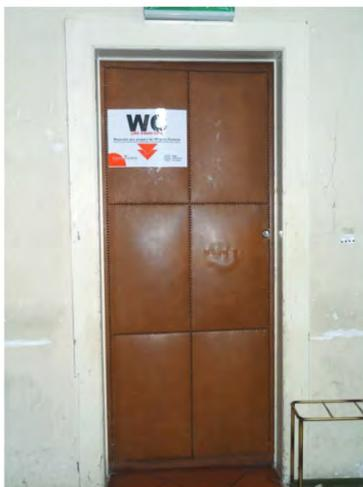
Fig. 185: Porte 20. Porte rembourrée en toile cirée, type moleskine. Non adaptée aux normes AEA1.
