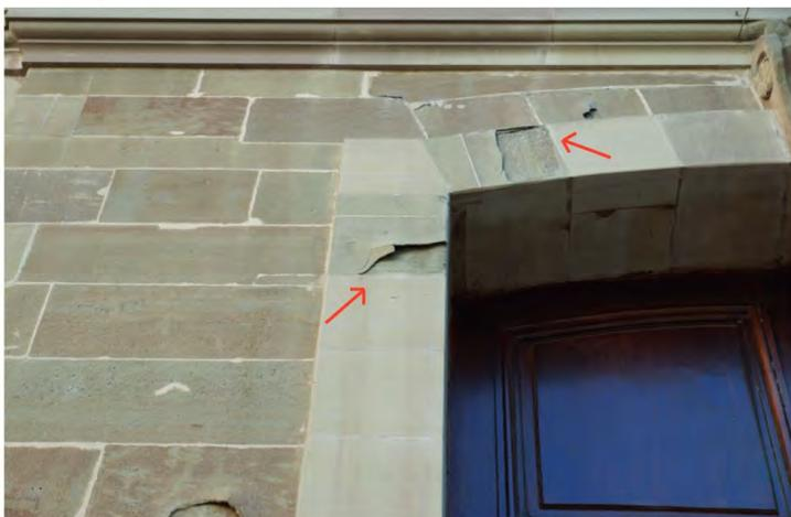
Fig. 83: Desquamation superficielle des pierres de taille en molasse. Le cadre en molasse du lac, pierre tendre, est très affecté par cette desquamation. Le gel et l'humidité continus ont accéléré le processus.
