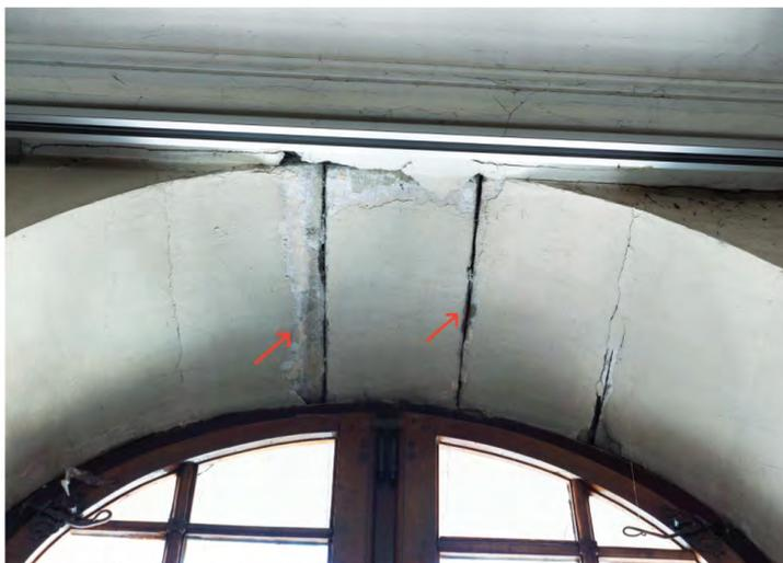
Fig. 238. La clé de la voûte de la fenêtre a bougé et s'est séparée des contre-clés. On retrouve la même situation sur la façade.
