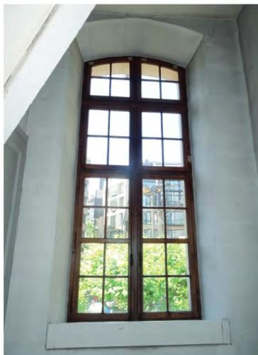
Fig. 261: Fenêtre 55. Fenêtre à la française en arc bombé (segmentaire).
