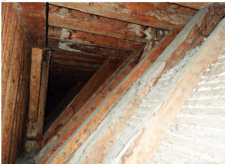
Fig. 276: Vue intérieure sur la voûte de la nef. Espace intersticiel entre la voûte et la paroi en bois visible dans les combles. La voûte est constituée de plâtre gypsé sur un litelage en bois.
