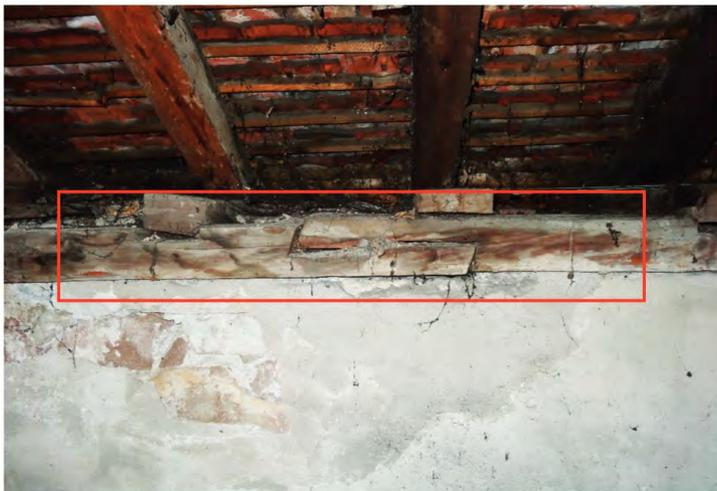
Fig. 289 Vue de la panne sablière. On note la présence de traces d'humidité et de saleté. Les blochets sont vieillés et parfois dégradés par la pourriture. En outre, on remarque que les pannes sablières ne sont plus alignées. Les assemblages en «trait de Jupiter» se sont relâchés. Des infiltrations sur ces secteurs sont visibles. Ces éléments qui fonctionnent comme des tirants, doivent être restaurés. Idéalement une sous-couverture au-dessus des arases des murs devrait être mise en place.
