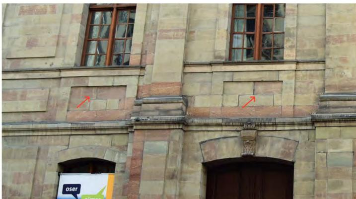
Fig. 95: On observe des fissures verticales sur les tablettes de plusieurs fenêtres à l'étage. Ces fissures éloignées des joints pourraient résulter d'un problème de tassements différentiels ou de problèmes liés à la charpente de la galerie. Façade sud-est.
