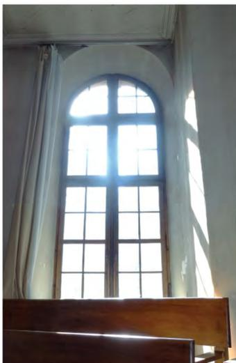
Fig. 264: Fenêtre 59. Fenêtre à la française en arc plein cintre.
