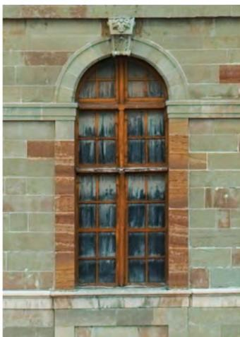
Fig. 258: Fenêtre 52. Fenêtre à la française en arc plein cintre. Située derrière l'orgue et obturée par des panneaux.
