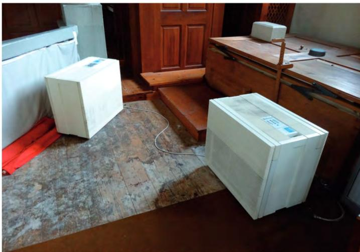
Fig. 337: Dispositifs d'humidificateurs pour maintien d'un taux moyen de 50 % à proximité de l'orgue.
