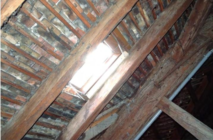
Fig. 292. Côté est. Tabatière. La couverture en tuiles plates est très ancienne. Un grand nombre de tuiles ne comporte encore qu'un seul ergot (fin XIX<sup>ème</sup>, début XX<sup>ème</sup>)
