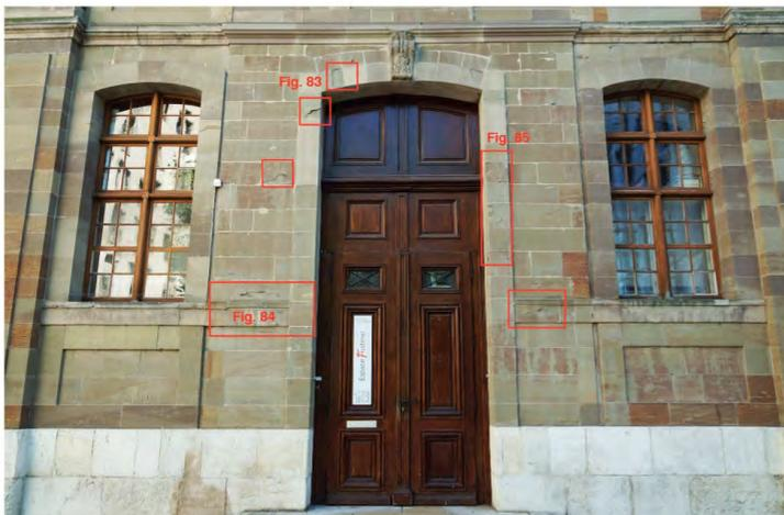
Fig. 82: Acès arrière au temple (façade nord-est). On distingue sur cette vue les différents types de pierre du bâtiment, la molasse du lac (pierre d'origine 1714) et grès d'Orion (pierres de remplacement 1974-1977). Voir point « 9.4 Types de pierre », plan FUS\_03 \_types de pierre façade nord-est.
