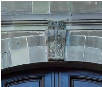
Fig. 104: Clé d'arc sur porte principale, façade nord-est, avec modillon galbé en talon et feuille d'acanthé.
