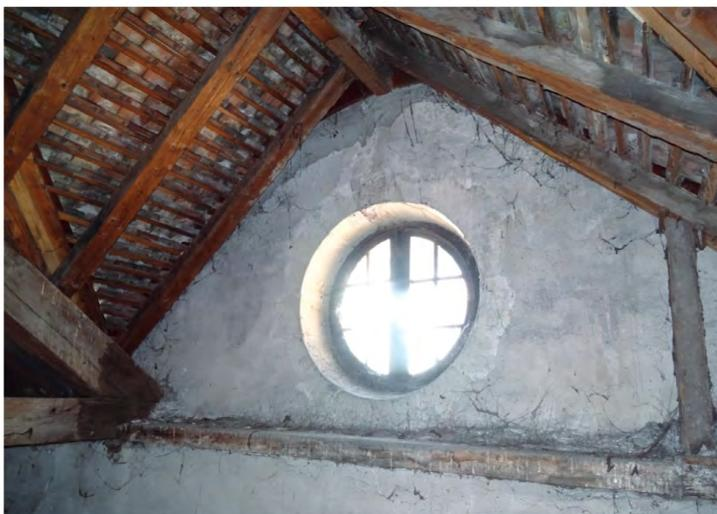
Fig. 314: Fenêtre 69, façade nord-ouest. Fenêtre en chêne et oeil-de-boeuf à douze carreaux. A restaurer.
