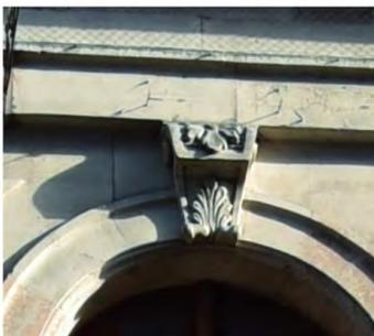
Fig. 108: Clé d'arc sur fenêtre, façade nord-ouest, avec modillon et feuille d'acanthé.
