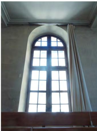
Fig. 254: Fenêtre 48. Fenêtre à la française en arc plein cintre.
