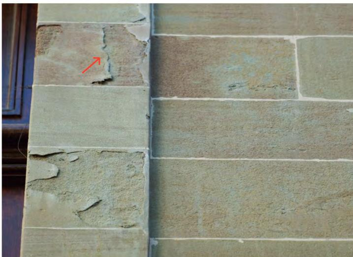
Fig. 85: Vue détaillée de la desquamation superficielle de la molasse et du grès. Partie gauche du cadre. Façade nord-est.
