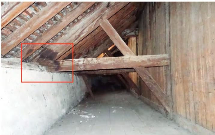
Fig. 274. Tirant côté nord-ouest dans le comble inférieur, entre la voûte et le mur gouttereau. Les appuis de fermes présentent tous des traces d'humidité anciennes. On distingue une charpente en sapin et une maçonnerie en brique TC pleine 4/12/24 cm. Épicéa coupé automne/hiver 1713/1714.
