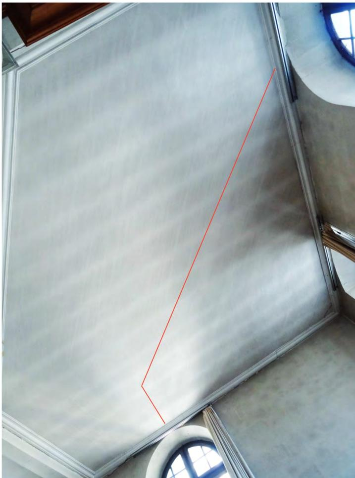
Fig. 218: Vue du plafond nord-ouest de la nef, à l'étage à côté de l'orgue. On remarque, au même niveau que sur les Fig. 216-217, les traces d'une ancienne cloison symétrique, dispositif qui accueille les escaliers d'accès aux combles.
