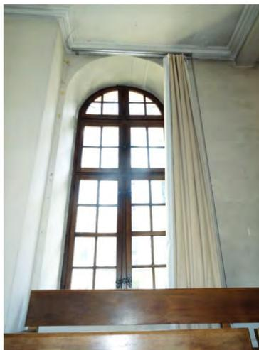
Fig. 245: Fenêtre 36. Fenêtre à la française en arc plein cintre.
