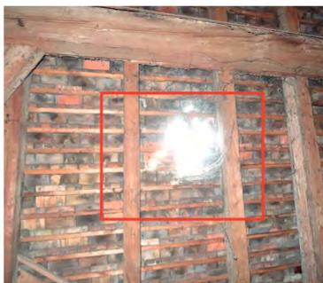
Fig. 287-288 : La plupart des anciens lattages sont fragiles. On aperçoit aussi des traces d'humidité en sous-face de la couverture. Les traces blanches de salpêtre sous les tuiles en divers endroits attestent une certaine porosité des éléments anciens. Plusieurs infiltrations par le passé mais également récemment ont provoqué des dégâts sur la charpente.
