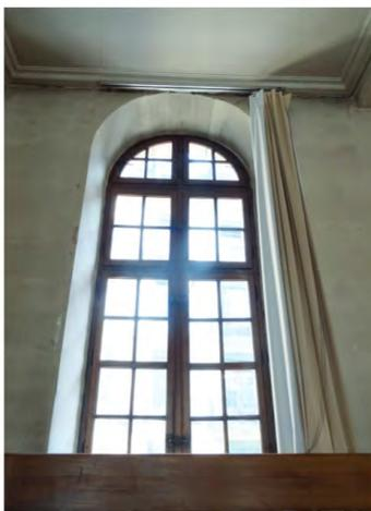
Fig. 246: Fenêtre 37. Fenêtre à la française en arc plein cintre.
