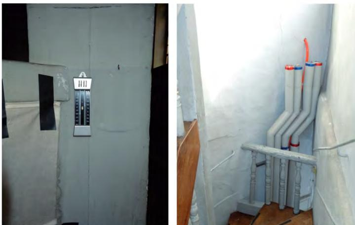
Fig. 339-339: Détails de l'installation de chauffage, thermomètres, purges de chauffage, etc...
