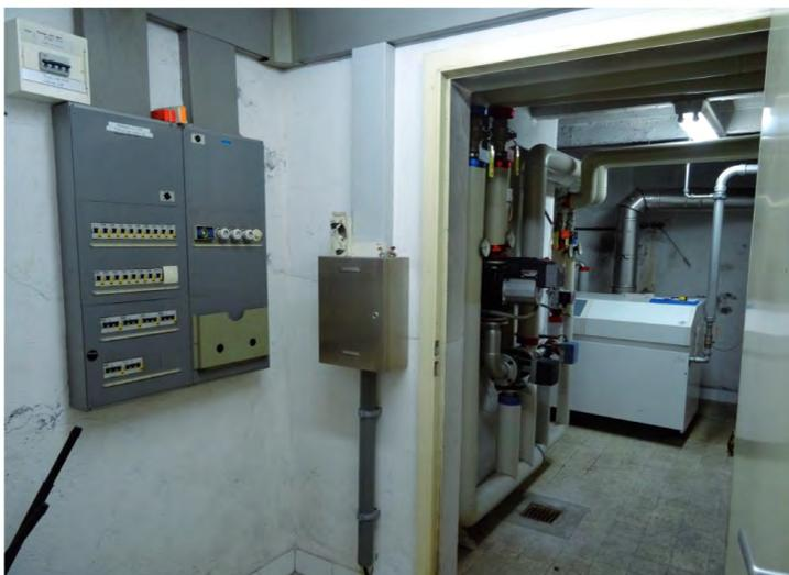
Fig. 336: Tableau électrique général et local de la chaufferie.
