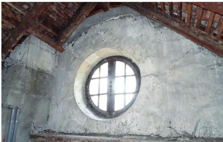
Fig. 313: Fenêtre 68, façade sud-est. Fenêtre en chêne et œil-de-boeuf à douze carreaux. A restaurer.
