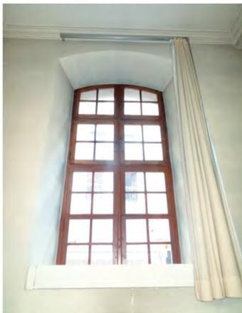
Fig. 172: Fenêtre 2. Fenêtre à la française en arc bombé (segmentaire). On distingue sur la partie inférieure un dispositif d'éclairage très volumineux. Celui-ci réduit l'apport d'éclairage naturel.
