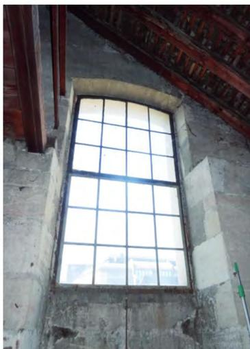
Fig. 312: Fenêtre 71, façade sud-ouest. Fenêtre métallique équipée en partie de verres soufflés. Verres float à remplacer par des verres soufflés.
