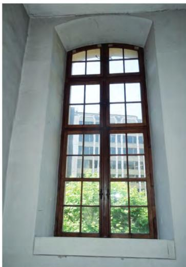
Fig. 265: Fenêtre 61. Fenêtre à la française en arc plein cintre.
