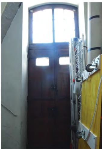
Fig. 190: Porte 25 avec attique vitré en noyer. Porte et ferrements datant de la construction d'origine.
