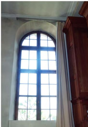
Fig. 257: Fenêtre 51. Fenêtre à la française en arc plein cintre.
