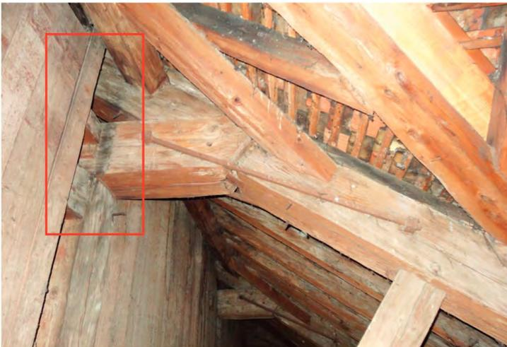
Fig. 293. Traces d'humidité dans la structure de la charpente. La charpente est constituée par du sapin et de l'épicéa. Ces bois datent de l'automne/hiver 1713/1714. Bertrand Yerly «Réf. LRD15/R7210», Laboratoire Romand de Dendrochronologie.
