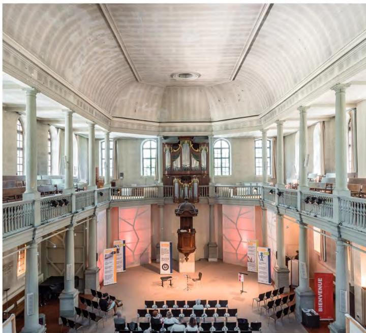
Fig. 142: Vue de la nef depuis le RDC, vers la chaire et l'orgue. Selon les analyses dendro chronologiques de LRD, les éléments de balustrades et garde corps datent de 1714/15. Les mains courantes sont en épicéa et les balustres sont en tilleul. Image de O. Chamard.
