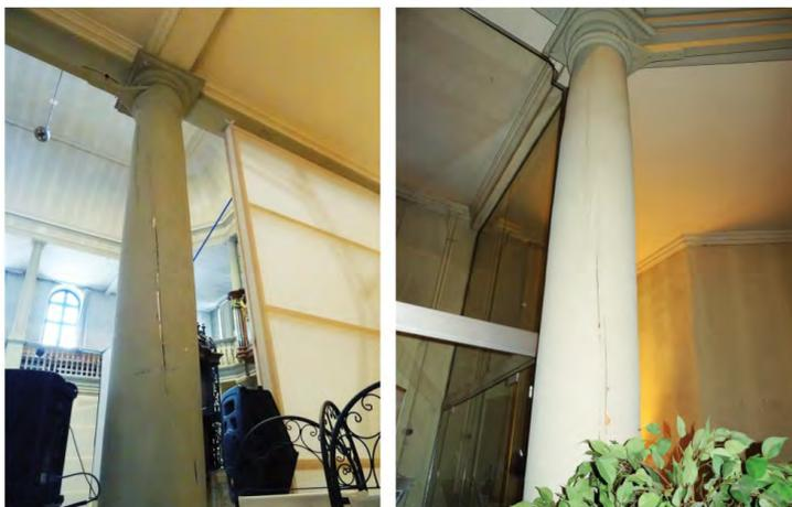
Fig. 168-169: Détail des colonnes en bois au RDC. Quelques unes sont en mauvais état. La peinture est tombée et révèle de grosses fentes dues à des retraits du bois (altérations causées par le temps). Il est nécessaire de poncer et réparer la structure, ouvrir les fissures, mastiquer, consolider ponctuellement avec des cerclages en acier et finir avec une peinture à l'huile. Un mastic type stucco forte (plâtre et chaux) et un entoilage au calicot de coton sera nécessaire.
