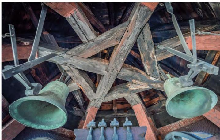
Fig. 130: Vue de l'enrayure du beffroi. Un traitement préventif contre les champignons et les xylophages a été fait lors de l'intervention de 2002. Les ferments ont reçu un traitement contre la rouille, notamment les croix de contreventement.
