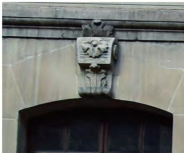
Fig. 107: Clé d'arc sur fenêtre, façade sud-ouest, avec modillon galbé en talon et feuille d'acanthé.
