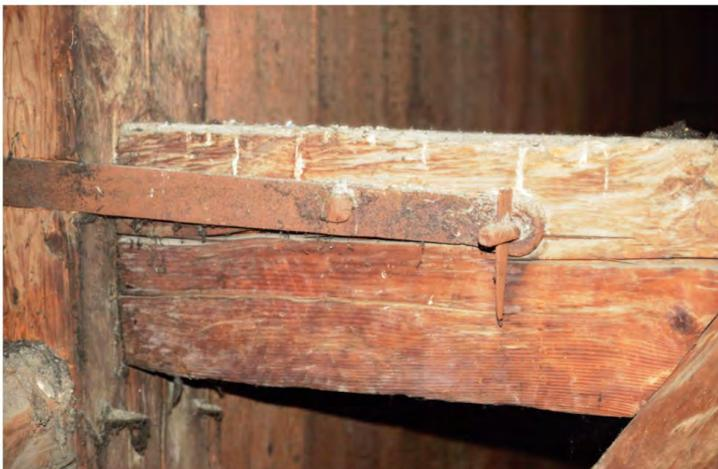
Fig. 277: Détail d'ancrage d'un blochet avec une jambe de force assurant la descente de charge sur les colonnes.
