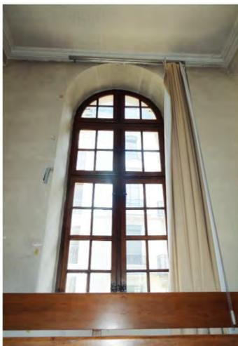
Fig. 244: Fenêtre 35. Fenêtre à la française en arc plein cintre.
