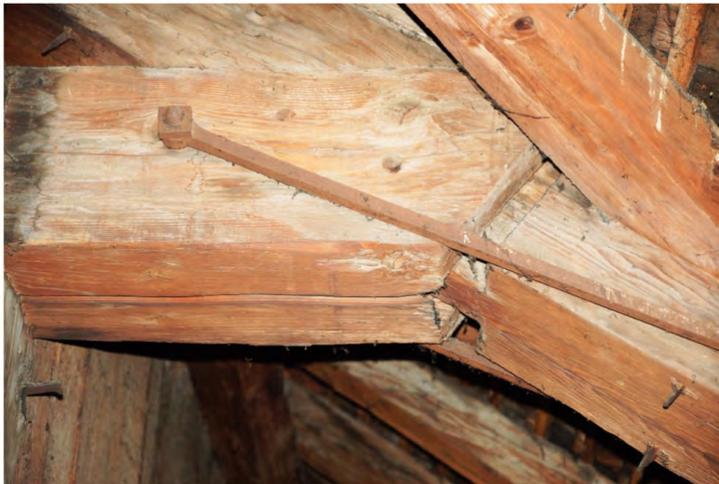
Fig. 278-279: Détail de renforcement en fer de l'assemblage entre l'arbalétrier et l'entrait retroussé. Les éléments situés sur chaque assemblage nécessitent un contrôle.
