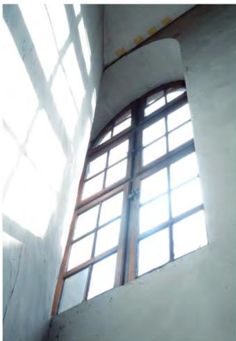
Fig. 248: Fenêtre 39. Fenêtre à la française en arc plein cintre. Cage d'escalier sud-ouest.
