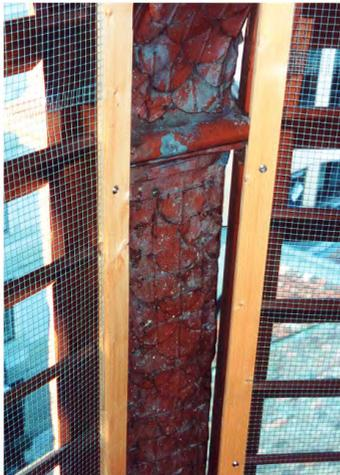
Fig. 123-124: Vue détaillée des écaillies en fer blanc peintes à l'intérieur du clocher. Divers secteurs ont été repris par le passé. On constate des écaillies de différentes factures.
