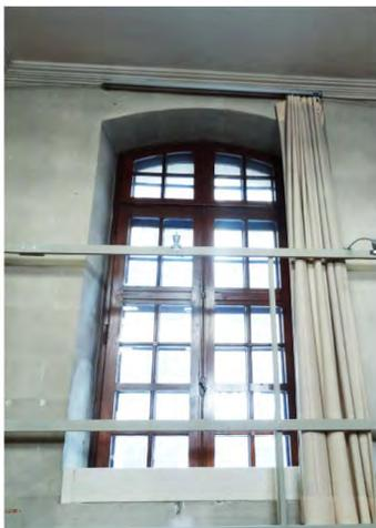
Fig. 176: Fenêtre 7. Fenêtre à la française en arc bombé (segmentaire). Double fenêtre à l'intérieur posée dans les années 1912.
