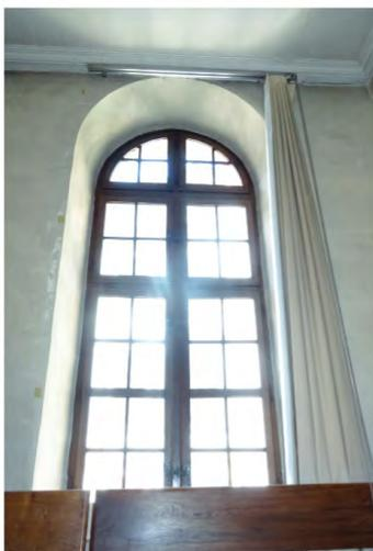
Fig. 252. Fenêtre 46. Fenêtre à la française en arc plein cintre.
