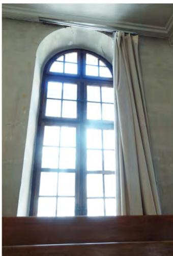
Fig. 250. Fenêtre 44. Fenêtre à la française en arc plein cintre.
