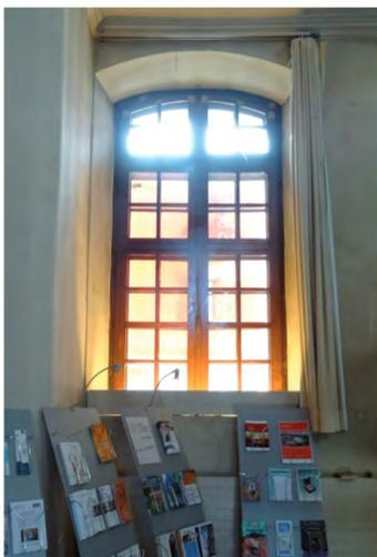
Fig. 186: Fenêtre 21. Fenêtre à la française en arc bombé (segmentaire). Double fenêtré à l'intérieur posée dans les années 1912.
