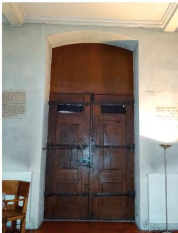
Fig. 181: Porte 15, monumentale, en noyer. Porte et ferrements datant de la construction d'origine.
