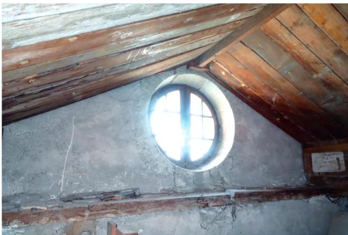
Fig. 315: Fenêtre 67, nord-est. Fenêtre en chêne et oeil-de-boeuf à douze carreaux. A restaurer.
