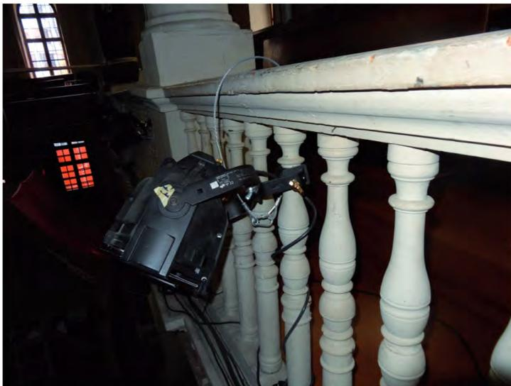
Fig. 333: Les projecteurs sont accrochés sur les balustres et la main courante. Un système de canaux électriques dans le plancher pourrait être mis en place pour une distribution des installations de son, électricité et illumination plus adéquat.
