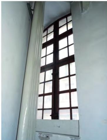
Fig. 177: Fenêtre 8. Fenêtre à la française en arc bombé (segmentaire). Cette fenêtre est située dans la cage d'escaliers façade Est. Elle est encombrée par des tuyaux de chauffage.
