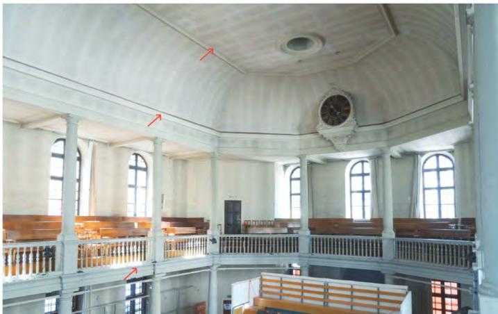
Fig. 226: Corniches massives moulurées sur tous les niveaux (41). La saleté laisse transparaître la structure de la charpente sous la peinture de la voûte. Un manque d'isolation dans les combles (ponts froids) provoque l'apparition de ces taches. Idéalement, il faudrait envisager la pose d'une isolation à haut coefficient de diffusion de vapeur d'eau sur le plancher des combles, et contre la voûte de la nef. Ce pourrait être de la laine de lin, de bois, de laine de mouton ou similaire.
