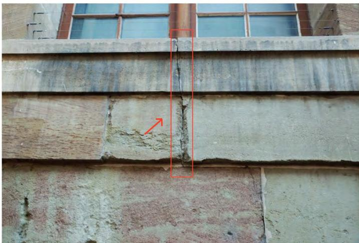
Fig. 90: Désagrégation granulaire. Séparation des grains. Érosion résultant d'une forte exposition aux intempéries (façade nord-ouest). Ce phénomène est éventuellement accéléré par l'application d'un film antigraffiti étanche. On remarque aussi une fissure verticale sur la tablette de cette fenêtres au RDC. Celle-ci résulte probablement des tassements différentiels.
