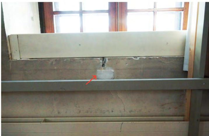
Fig. 240: Les tablettes d'appuis de certaines fenêtres sont fissurées au milieu. Des témoins de contrôle de mouvements statiques sont également fissurés. Cela indique que le bâtiment n'a pas fini de bouger et de se tasser.
