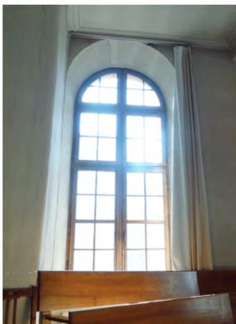
Fig. 262: Fenêtre 57. Fenêtre à la française en arc plein cintre.
