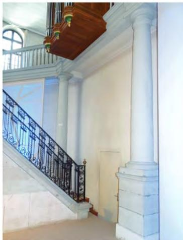
Fig. 162: Paroi en parpaings de béton derrière la chaire construite lors du projet de Francis Schenk, 1975. Les colonnes de part et d'autre de l'orgue (du rez-de-chaussée à la galerie) ont un diamètre plus petit (132 mm) que les autres colonnes (140 mm). (1)
