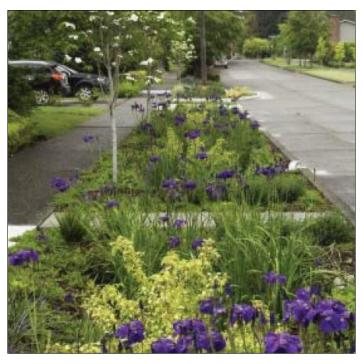
Figure 21 Exemple d'une noue (source OCEau).
