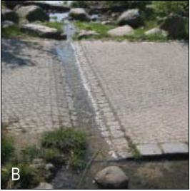
Figure 20 Exemples de caniveaux (source OCEau).
