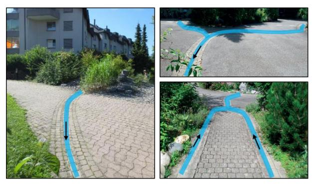
Figure 14: Exemples d'évacuation et de gestion des eaux en surface (source VSA).
