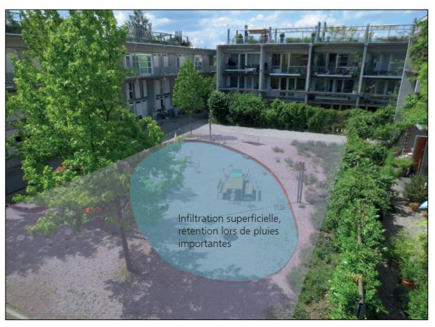
Figure 17: Principe de rétention et d'infiltration (source VSA).
