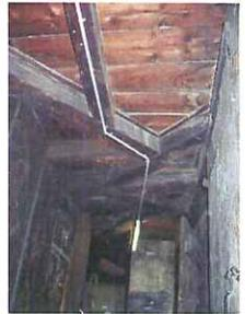
poutrais du plancher sur combles
