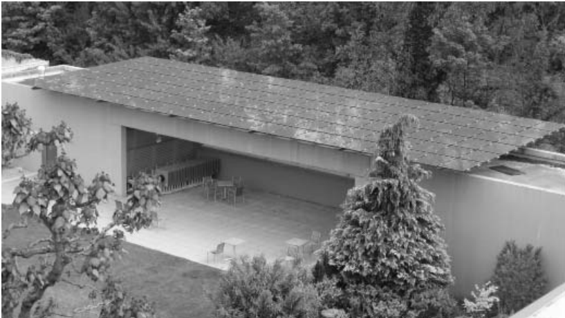
Illustration d'une installation sous forme de pergola – exemple de la buvette de la piscine extérieure des Vernets
