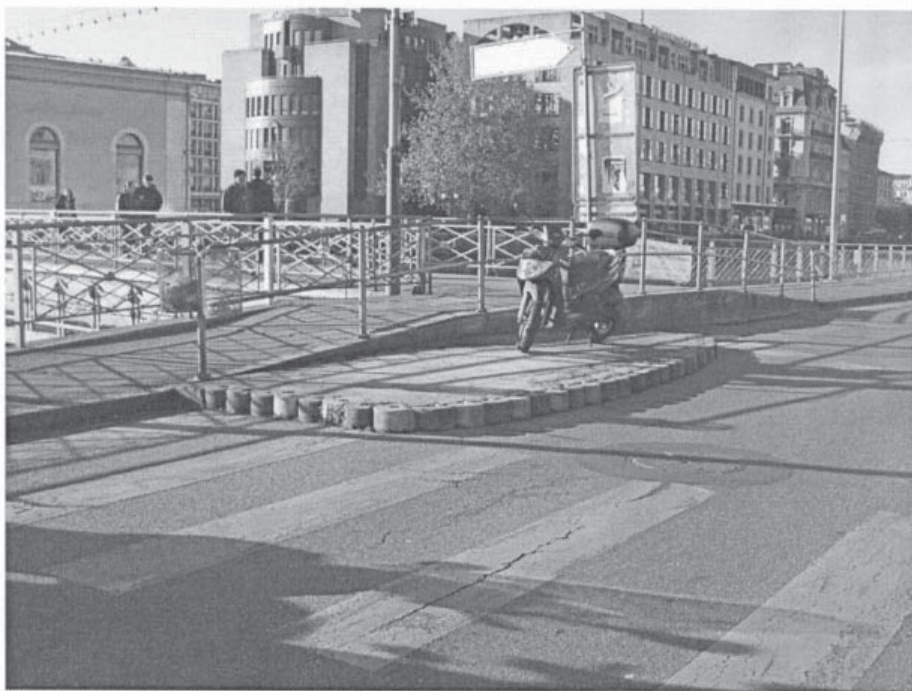
Situation actuelle avant travaux, entre le pont et la place de Chevelu
