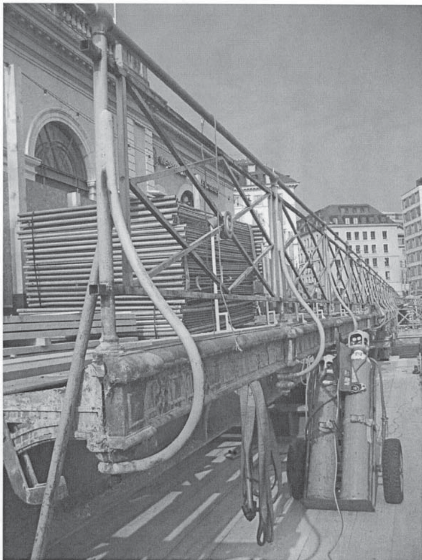
Vue générale sur barrière « Dufour »
