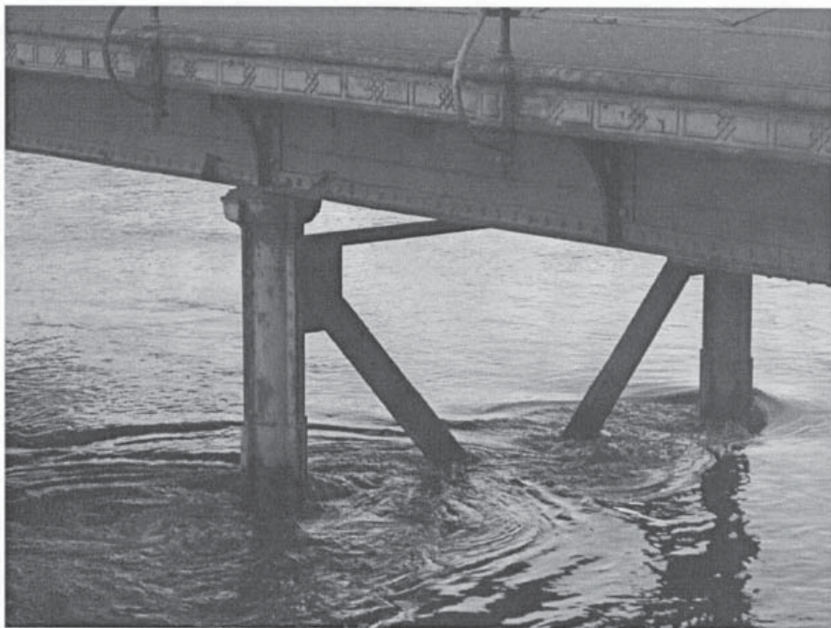
Pile du bras gauche du pont
