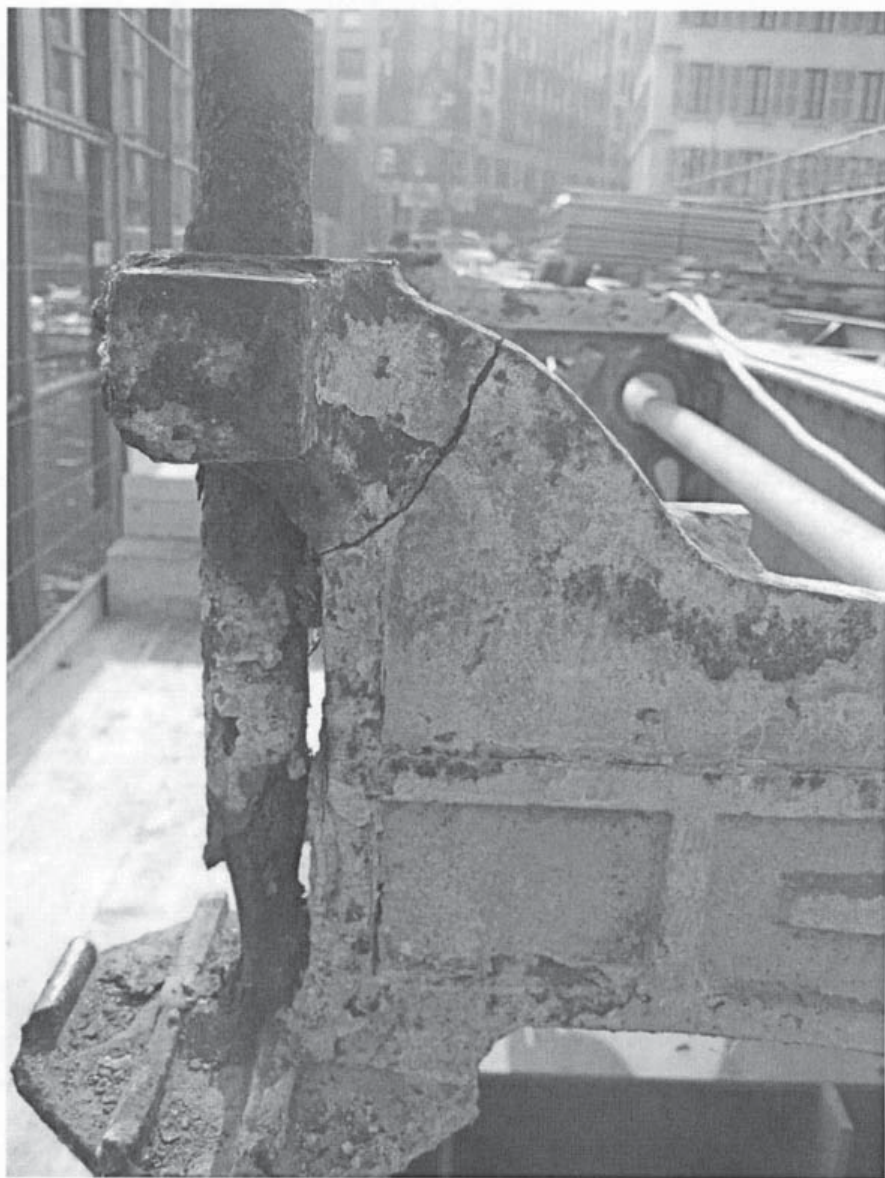
Console en fonte supportant la barrière
