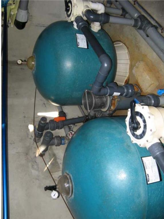
Rive droite : système de filtration et traitement de l'eau avec chlorinateur
