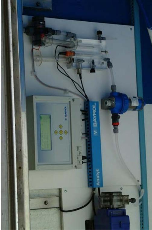
Rive gauche : système de filtration et traitement de l'eau par mélange acide/Javel régulé par ordinateur
