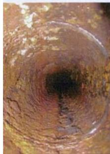
4/ Contrôle et vérification de l'efficacité du curage à l'intérieur de la trainasse RAS: présence de protubérance ferreuse due à la corrosion
