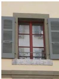
*nouvelle fenêtre avec vitrage isolant.*
