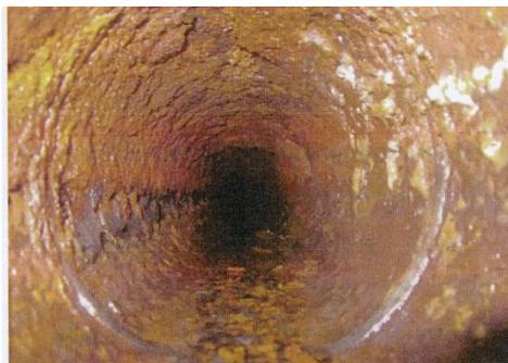
4/ Contrôle et vérification de l'efficacité du curage à l'intérieur de la trainasse RAS, présence de protubérance ferreuse due à la corrosion
