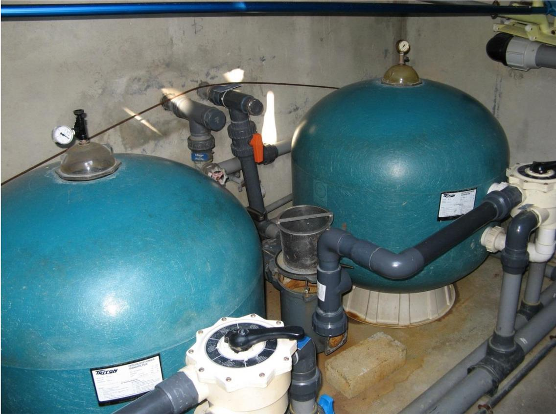
Rive droite : système de filtration et traitement de l'eau avec chlorinateur
