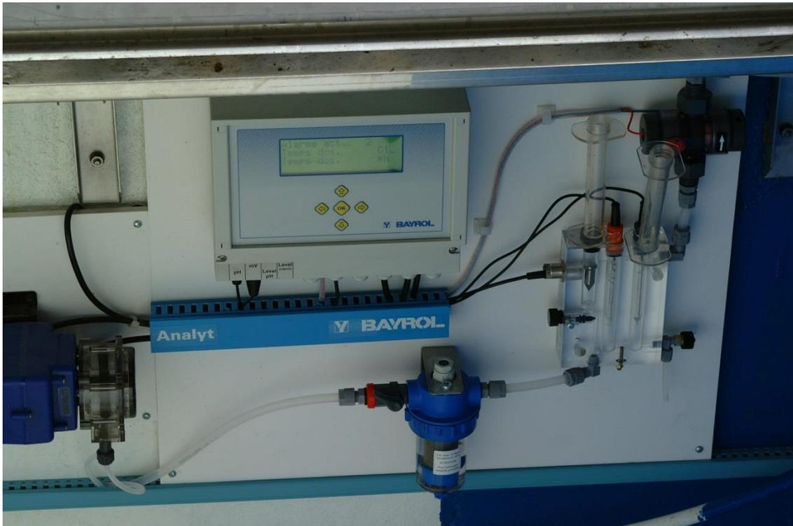
Rive gauche : système de filtration et traitement de l'eau par mélange acide/Javel régulé par ordinateur
